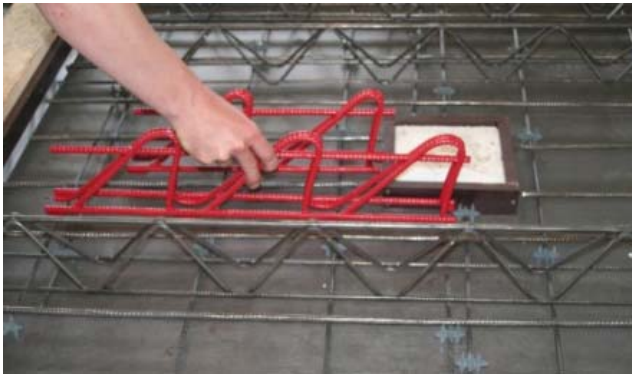
Bild 3: Einbau der FDB
