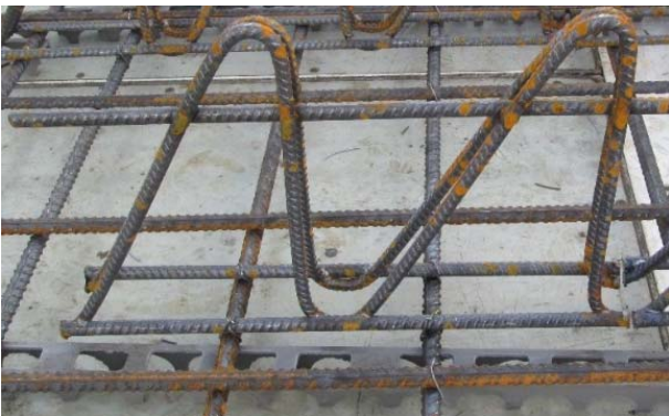
Bild 2: Einbau FDB auf der untersten Lage der Biegezugbewehrung
