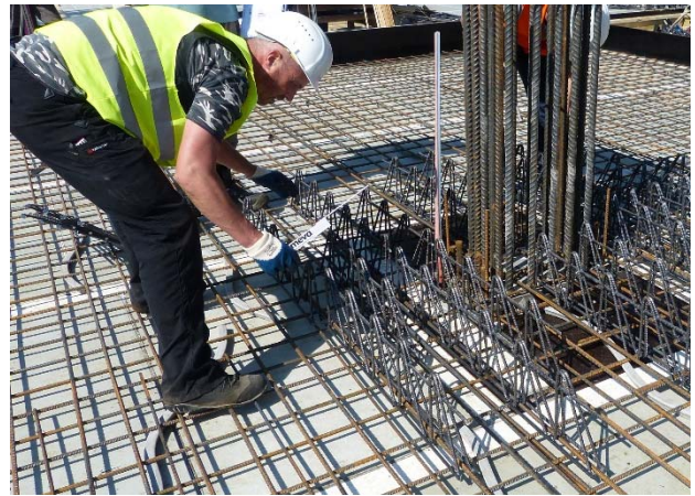
Bild 4: Einmessen FDB Elemente
