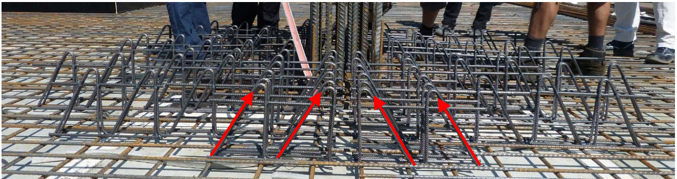
Bild 3: Einbau FILIGRAN®-Durchstanzbewehrung FDB
